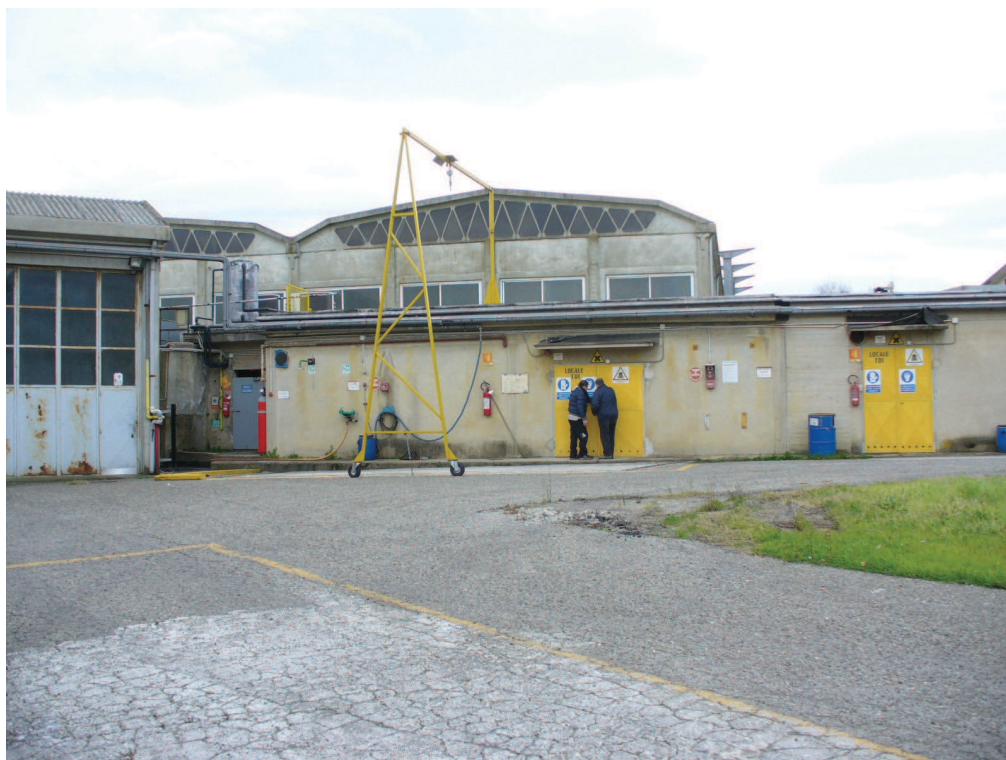
Foto 3 – Bunker per lo stoccaggio del TDI. I due locali (le cui entrate sono in colore giallo) risultano adiacenti ma separati da un muro
