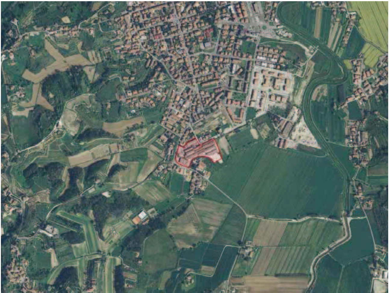
Figura 1 - Ubicazione dello stabilimento ICLA SpA/M3 srl a rischio di incidente rilevante, posto nel Comune di San Miniato
