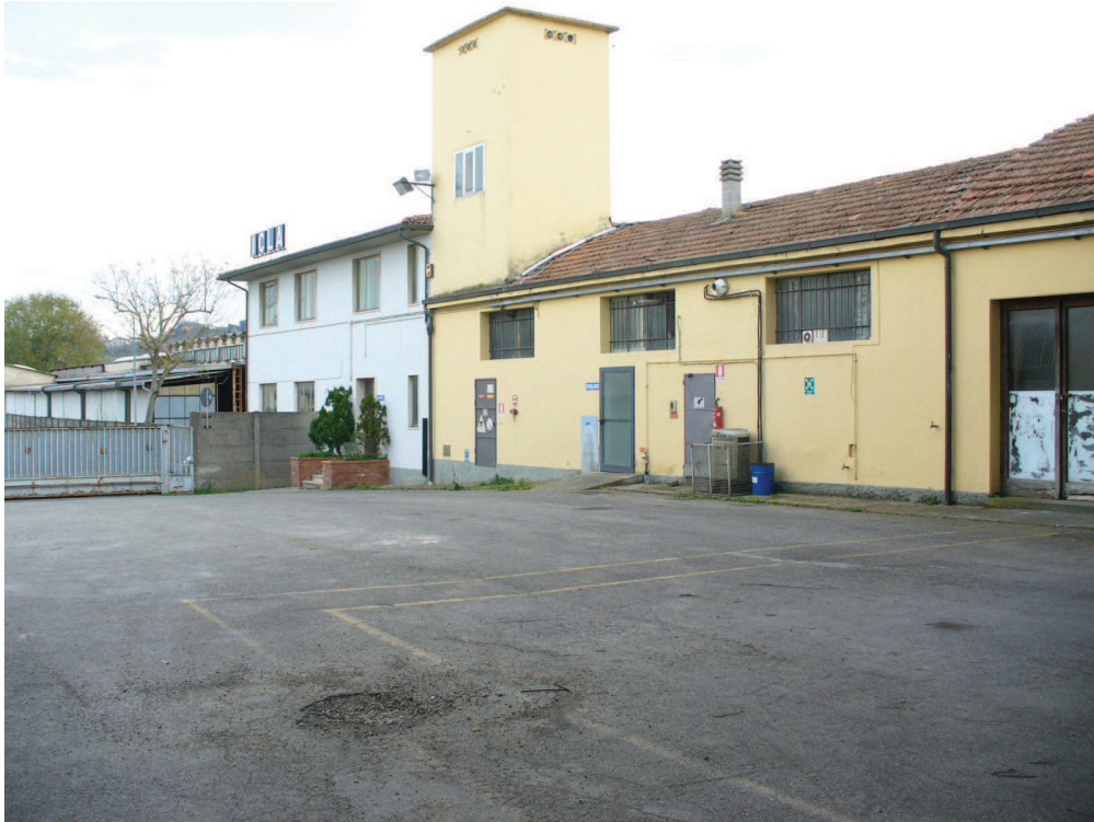
Foto 1 – ingresso allo stabilimento da Via N. Sauro. L'area risulta completamente pavimentata
