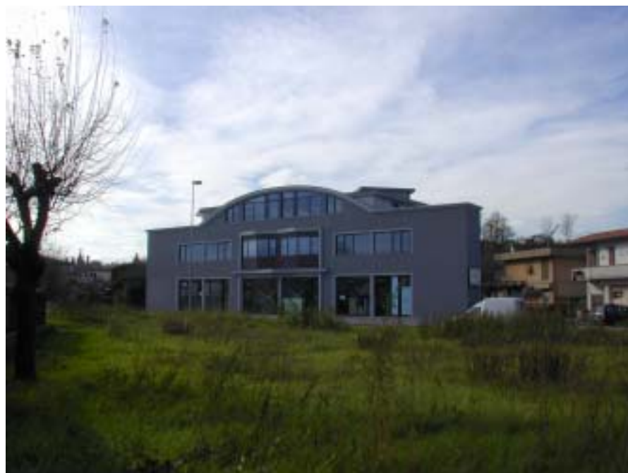
7- Ponte a Egola- Nuove edificazioni
